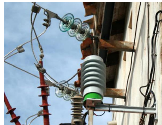
Figura 4. Prototipo del acoplador capacitivo
